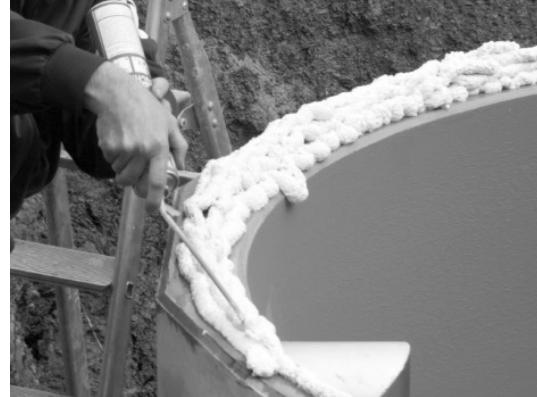
PU pjenu treba nanijeti na nalijegajući spoj donjeg betonskog elementa, preporuča se nanijeti „najmanje 2 ili 3 kruga“ pjene! Nakon nanošenja pjene, treba pričekati da pjena ekspandira i očvrste 10 min i tek onda spustiti gornji element kojeg se kod namještanja ne smije rotirati.
