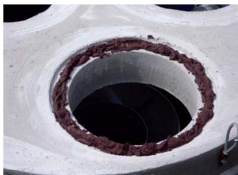
Betonski prsteni promjera 80 i 60cm za finu nivelicaciju poklopca i sam poklopac se spajaju vodonepropusnim elastičnim cementnim mortom otpornim na kemijsko djelovanje naftnih derivata (nije uključeno u obim ACO isporuke) ili alternativno se može koristiti kvalitetni cementni mort čija fuga ne bi trebala prelaziti debljinu od 2 cm. U oba slučaja mort treba pripremiti i nanijeti u skladu s uputama proizvođača, kontaktna površina treba biti čista i odmašćena.
