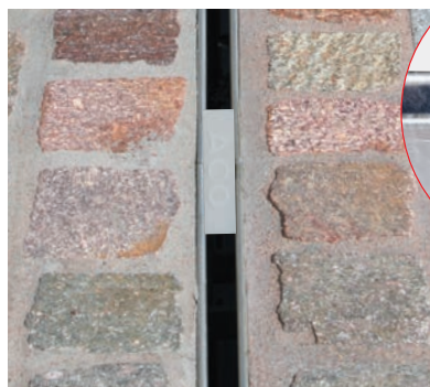
Spoj kanala sa rasporom SA spojnicom
