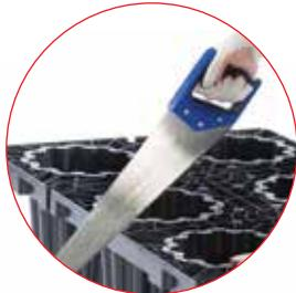
Cijevni priključci služe za stvaranje sigurna spoja kanalizacijskih i ventilacijskih cijevi na sustav. Postavljaju se u otvore koje radimo na čeonim stijenkama ili polublokovima.
