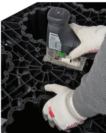
Konstrukcija bloka bez bočnih stranica (čeoni stijenki) koje se sastavljaju samo na rubovima sustava omogućava stvaranje sustava kroz koji je omogućeno slobodno kretanje inspekcijske opreme i opreme za čišćenje (ako se odabere prikladan tip opreme) te znatno bolja preglednost sama sustava (ništa ne zaklanja pogled kroz inspekcijske magistrale).
