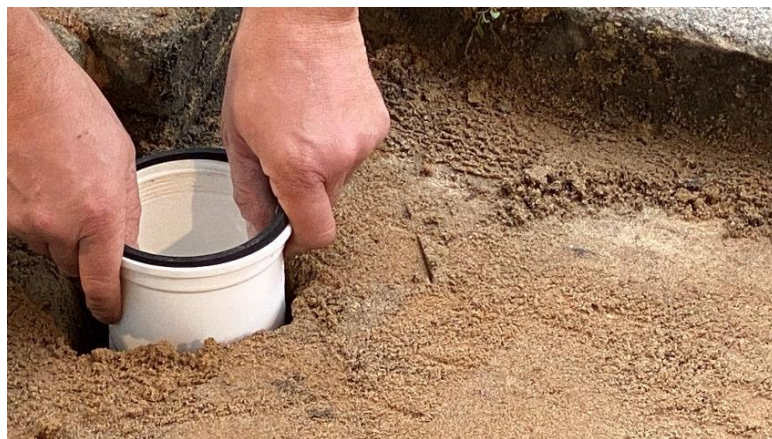
■ Ugradnja odvoda
