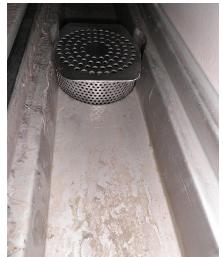
ACO Inox Box kanali - zaštitno sito iznad sifona
