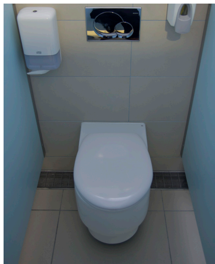
ACO Inox Box kanali sa Heelguard rešetkom u WC-u
