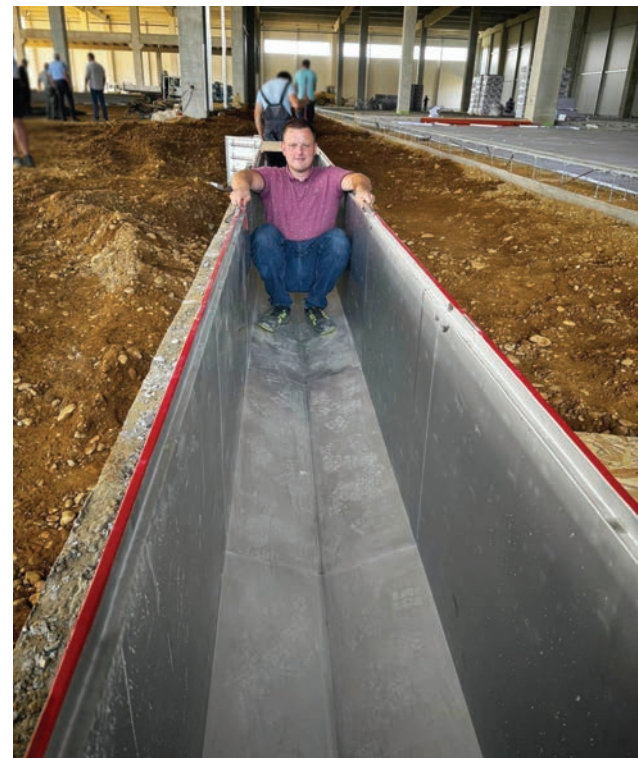
Ivan Jerman dočarava svu veličinu, širinu i dubinu custom made Box odvodnog kanala razvijenog za Centar za skladištenje i distribuciju voća i povrća u Đurđevcu
