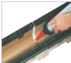
SF - utor za brtvljenje spojeva kanala
