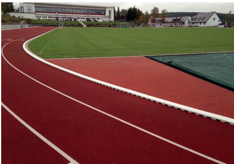
Plastična pokrovna ploča za sustav kanala ACO SPORT® 1500, izrađena iz stakloplastike
