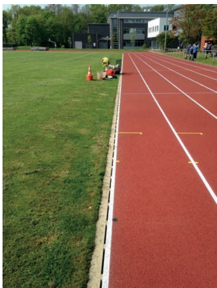
ACO SPORT® 1500 je kanal s rasporedom svjetlog otvora 125 mm, izrađen od polimerbetona
