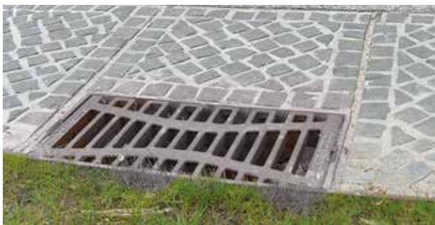
Multitop® slivna rešetka 500x500 mm za razrede opterećenja C250 / D400
