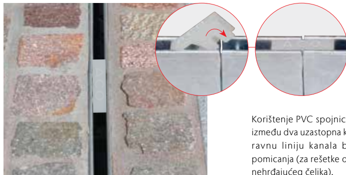
Spoj kanala sa rasporom SA ACO spojnicom
