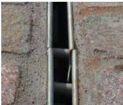
Spoj kanala sa rasporom BEZ spojnice
