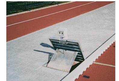
ACO SPORT® Verteilerschächte für Elektro- und Kommunikationsanlagen, Armaturen, Messgeräte und Wasserleitungen
