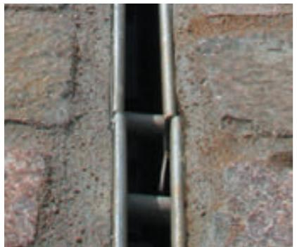
Spoj kanala sa rasporom BEZ spojnice
