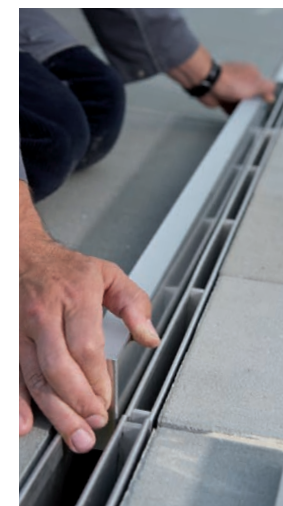
Montaža LED elemenata u okvir sa rasporom
