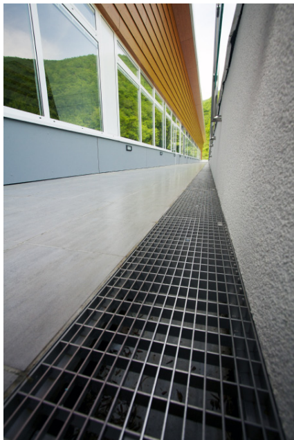
Profiline inox kanali ugrađeni duž svih balkona
