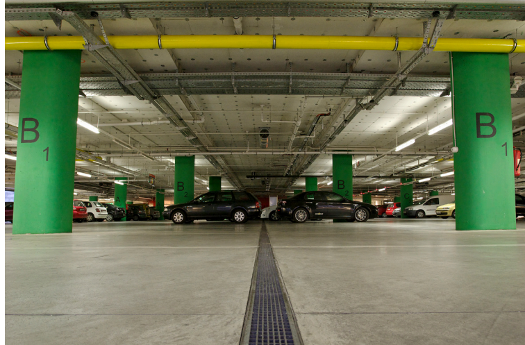
Multiline kanali u plitkoj izvedbi u podzemnoj garaži.
