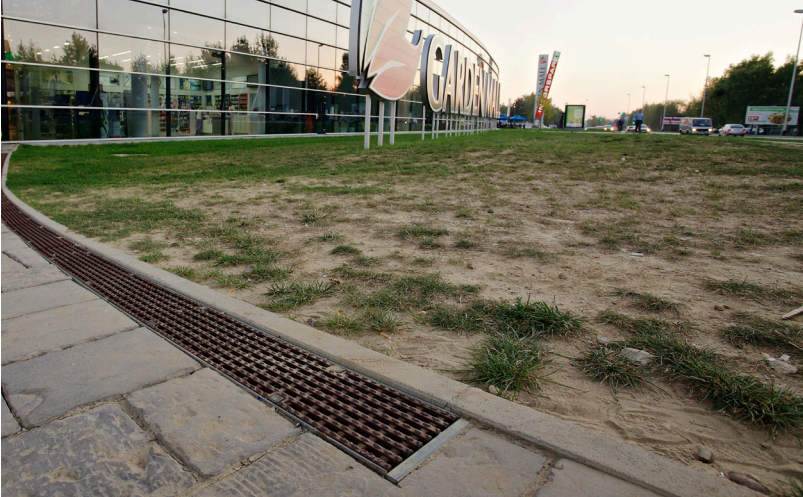
Multiline kanali na prilaznim putevima do objekta
