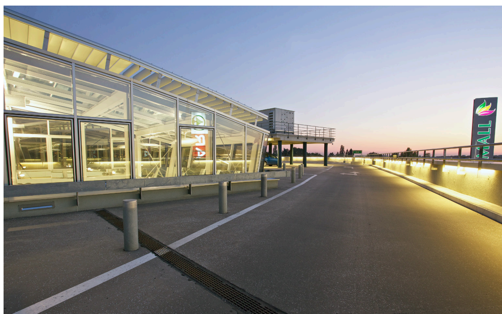
Multiline kanali u plitkoj izvedbi na krovnom parkiralištu objekta.
