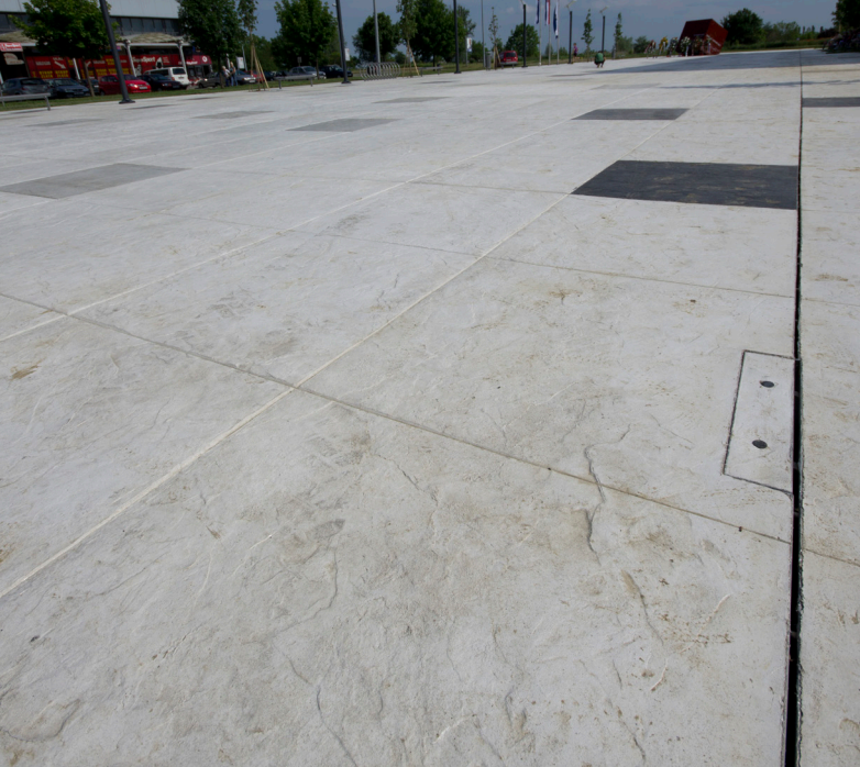
Detalj revizionog elementa za čišćenje Brickslot sustava
