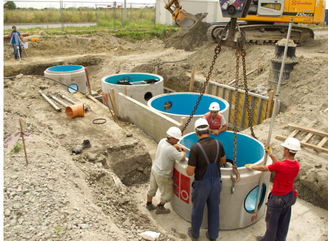
Ugradnja separatora OLEOPATOR C s ext. bypassom
