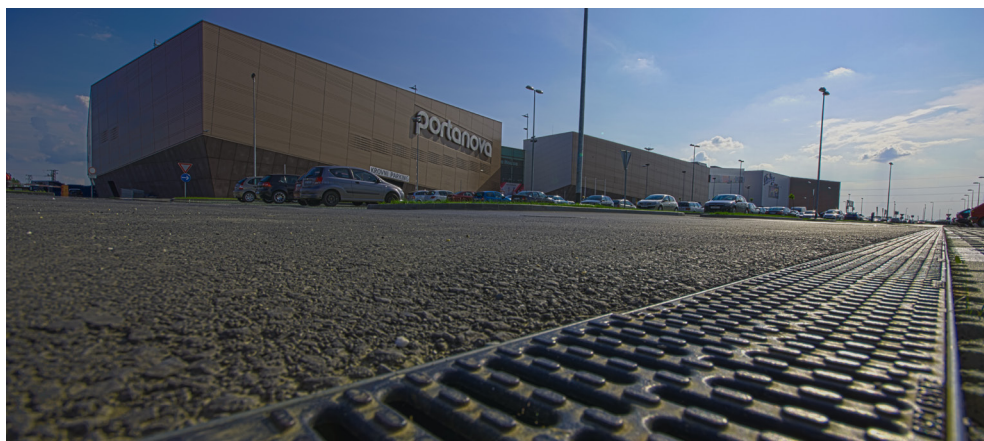
Odvodnja vanjskog parkirališta izvedena Multiline V150 kanalima
